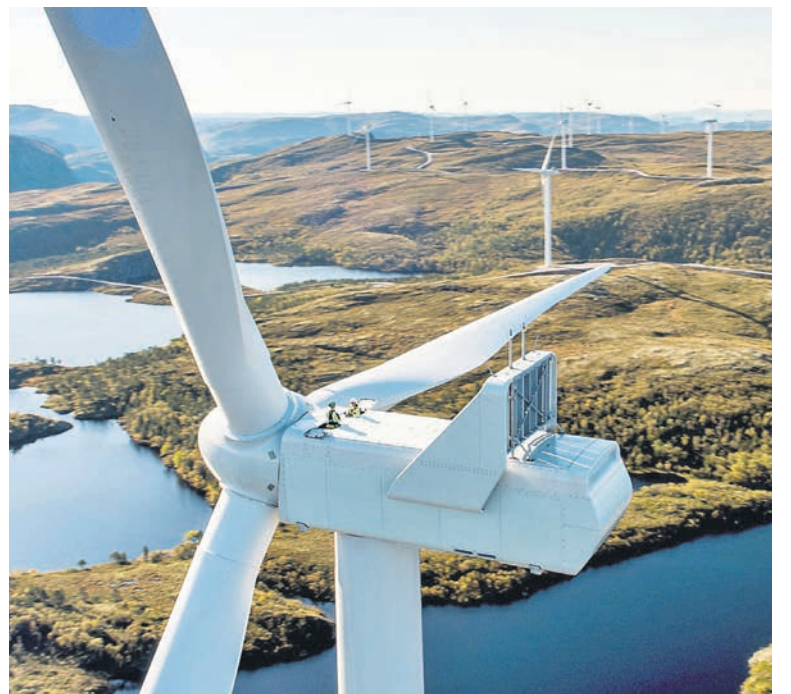
Aerogeneradores en un parque eólico gestionado por Statkraft.
